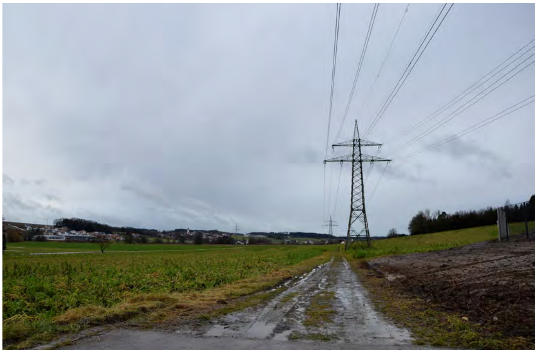
Abbildung 40: Foto in Blickrichtung Südwest - Einschränkung durch 110 KV-Leitung
