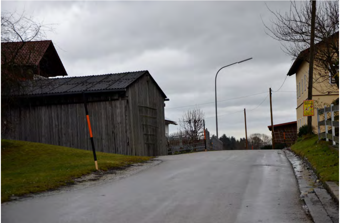
Abbildung 49: Ortsdurchfahrt Tabeckendorf - Engstelle, westliche der Fläche 12
