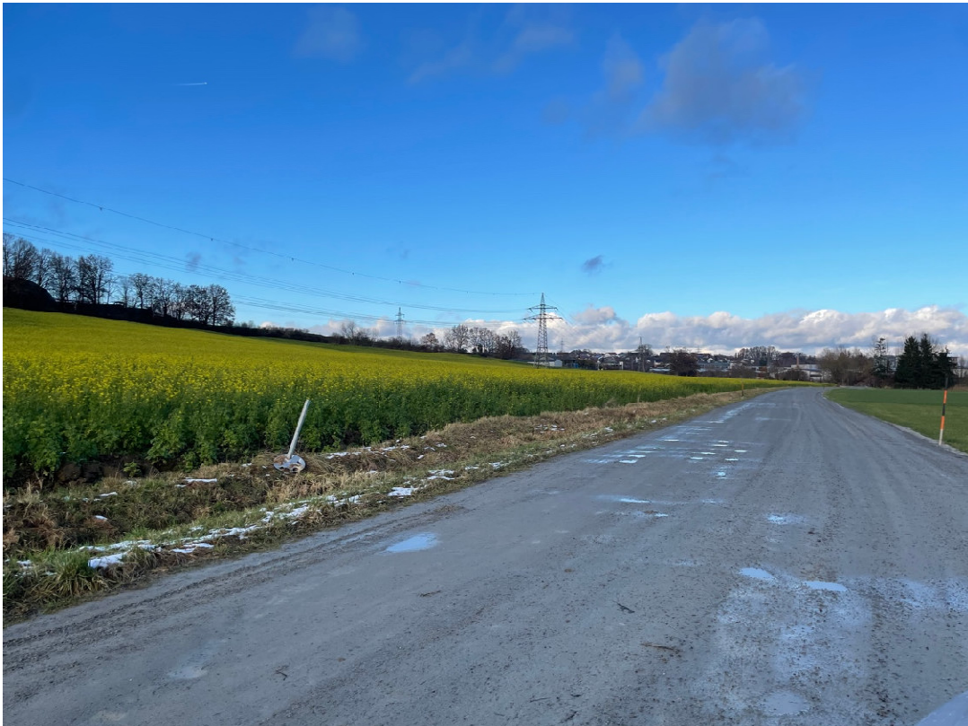
Blick vom Süden Richtung Arnstorf- Teilfläche links
